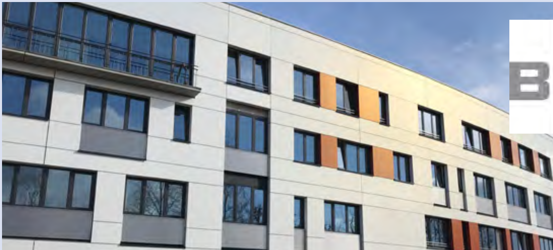
// Foto: BBB Ingenieurbüro GmbH
